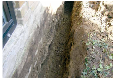
Udgravet rende langs kældervæg.
